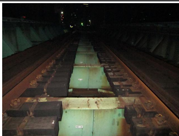
가로보 지점부 전경
