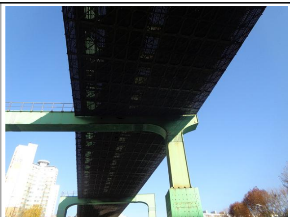
점검로 하부 전경
