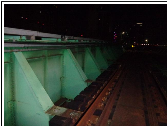
거더 내측 전경
