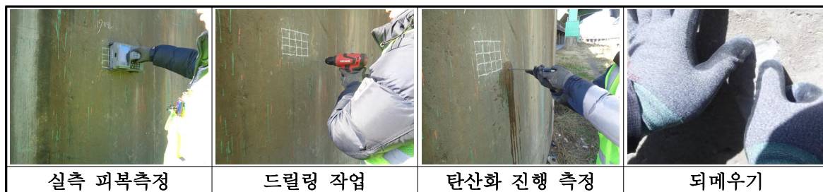
【그림 II-4.3.26】 탄산화 깊이 측정 절차
